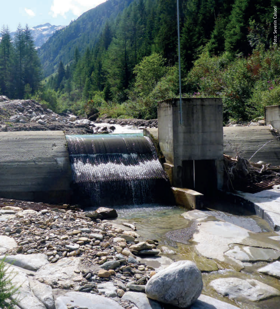
▲ Abbildung 2: Wasserfassung der Kleinwasserkraftanlage Wannebode an der Blinne VS
