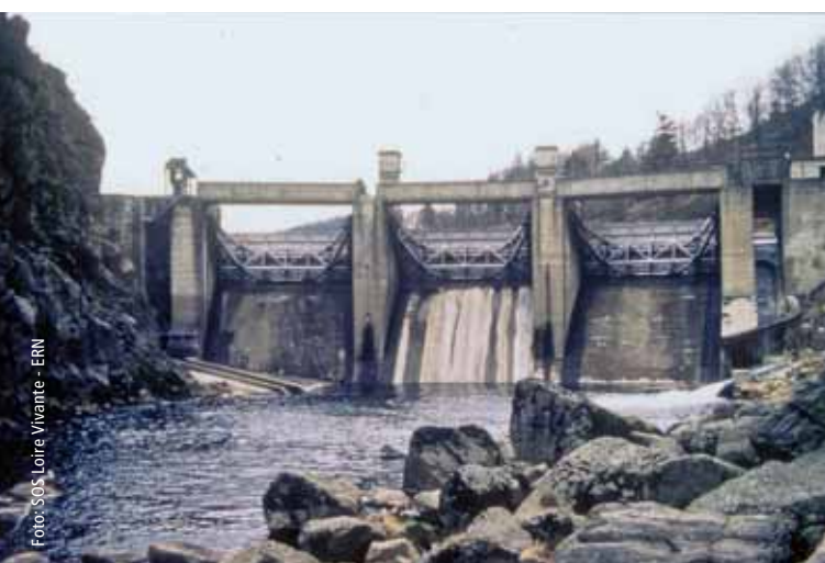
▼ Abb. 4: Durch den Teilrückbau des Staudamms Poutès reduziert sich der eingestaute Bereich von derzeit 3,6 km Länge auf 300 m. Der Damm wird von 18 auf 4 m Höhe reduziert und mit grossen, voll absenkbaren Klappen, Fischtrepfen und Lachsabstiegshilfen ausgestattet. 80 Prozent der Stromerzeugung bleiben erhalten.
