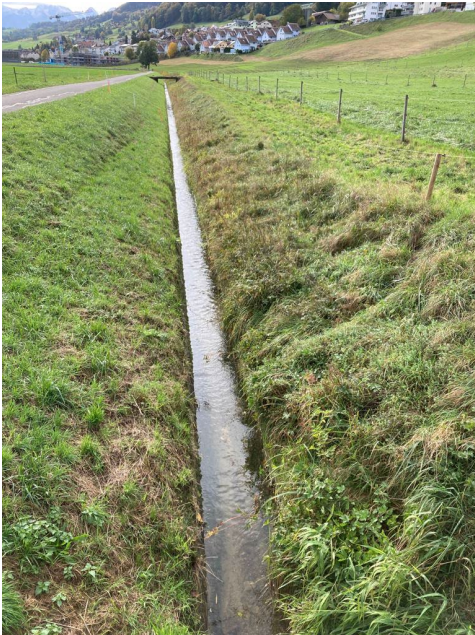
Toffenkanal in Halbschale
